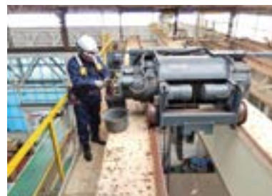
天井クレーンメンテナンス
