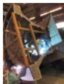
38 t ポジショナーによる溶接作業
