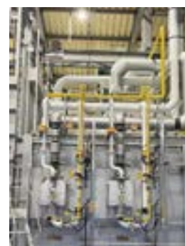
製缶・据付作業
