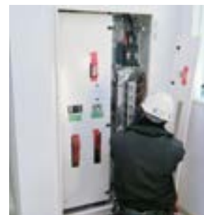
電気設備工事
