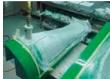
FRP構造体製作技術 真空バック法による製作
