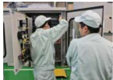
組立作業風景
